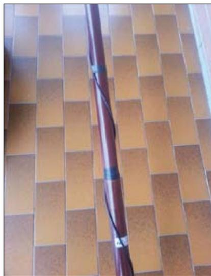
Di grande aiuto è stata la canna da pesca in vetroresina da 8 metri, dove ho attaccato in punta la miniwhip e poi ho infilato la canna direttamente nel tubo a L dove ho montato la parabola SAT.
