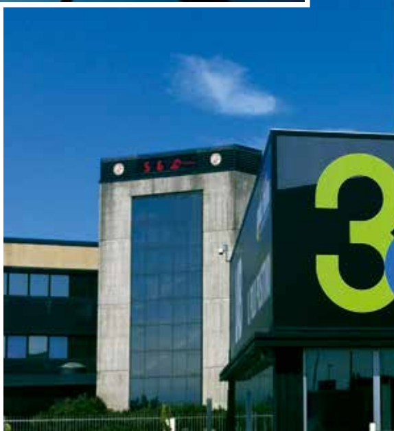
La sede a Trezzo sull'Adda di Mauri Elettroforniture
