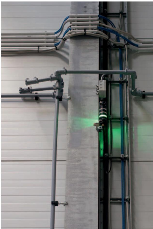
*Dettaglio del sistema di segnalazione con semaforo Led*
