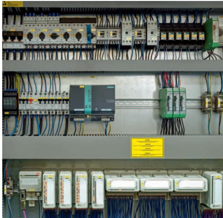
Quadro elettrico dell'impianto di depurazione con integrati moduli di gestione elettronica dei motori
