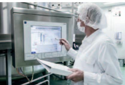
*I pannelli sono basati su sistema operativo Windows Embedded Compact e programmati o tramite un software R. Stahl o il software Movicon di Progea*
