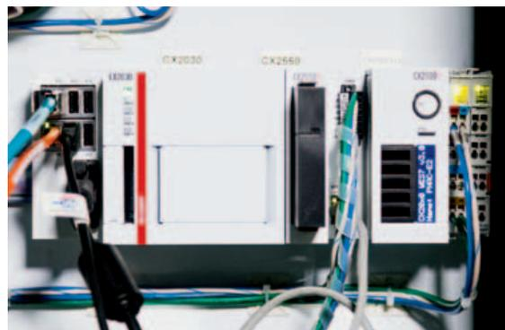
*Un PC Beckhoff CX2030 Embedded PC gestisce il software del sistema del magazzino e controlla i nastri trasportatori (Picture: Beckhoff Automation, USA)*
