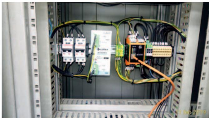
*L'armadio elettrico con i cablaggi per il collegamento dell'applicazione di Condition Based Maintenance, che permette di raccogliere i dati relativi al funzionamento della turbina collegata ai generatori elettrici*
