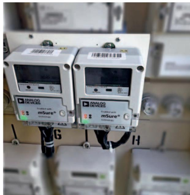
Figura 1 - La tecnologia hardware e software della soluzione mSure di Analog Devices è innovativa e consente la diagnostica dei contatori elettrici direttamente sul campo
