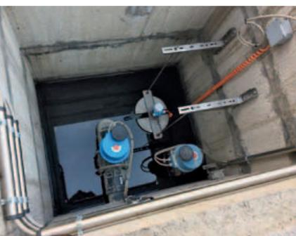
Endress+Hauser propone due strumenti, il T4311 e il NAR300, per rilevare olio su acqua
