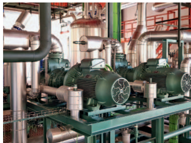
La soluzione WMagnet utilizzata in Mafresa utilizza, oltre a motori sincroni, anche inverter CFW11PM
