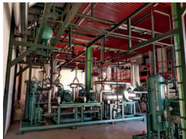
Le nuove celle frigorifere di Mafresa da 300 m 2 utilizzano quattro motori elettrici W22 Magnet IE4 di Weg per compressori da 160 kW
