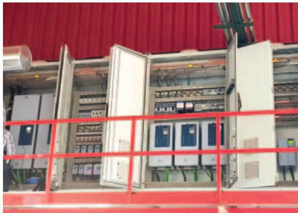
Weg ha ugualmente fornito inverter CFW700 da 11 kW e 22 kW per il quadro Autrial
