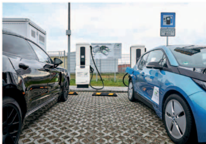
Le colonnine sono progettate per avere una semplice manutenzione e sono dotate di sensori nel connettore di ricarica per la massima sicurezza. Così sono possibili nuovi record: la stazione di ricarica di destra fornisce 450 kW, la seconda stazione (a sinistra) carica a 175 kW (fonte: Phoenix Contact)
