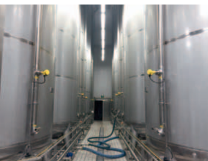
I sensori Vega è ideale per la misura di livello e pressione di liquidi e prodotti viscosi in presenza di elevate pressioni di processo
