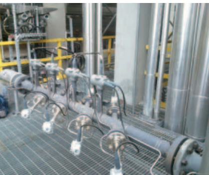
Le misure di portata su punti critici per la sicurezza sono collegate al Sistema di Controllo Digitale e di Arresto di Emergenza dell'impianto
