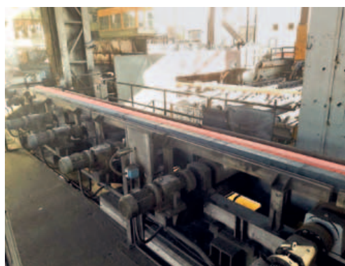
Figura 3 - Fotografia della parte di informamento delle billette
