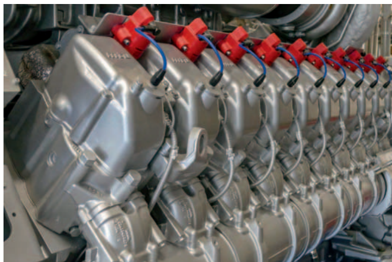
Il sistema di cogenerazione si basa su motori a 20 cilindri alimentati con gas metano
