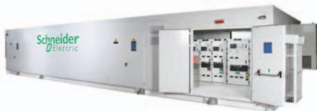
*All'interno di ciascun modulo E-House è integrato tutto il necessario per la gestione della distribuzione elettrica di un impianto o un edificio.*
