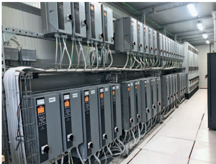
I 56 inverter VLT Aqua Drive utilizzati nell'impianto di dissalazione di Sarroch regolano la portata in funzione delle condizioni operative minimizzando i consumi energetici dell'impianto
