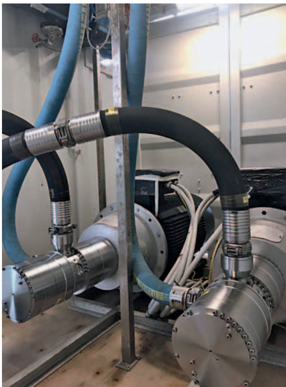
Le pompe ad alta pressione e i dispositivi di recupero dell'energia iSave di Danfoss consentono di abbattere i consumi energetici legati al processo di dissalazione e osmosi inversa
