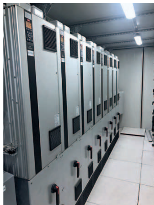
Gli inverter VLT Aqua Drive frame tipo D, da 200 kW di potenza, sono estremamente compatti per la loro classe di potenza. Alla base delle prestazioni degli azionamenti Danfoss e della gamma VLT, c'è la tecnologia dei componenti IGBT prodotti da un'azienda che fa parte del Gruppo.
