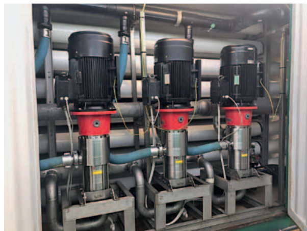
La compattezza delle pompe ad alta pressione Danfoss di tipo volumetrico ne consente l'utilizzo in spazi ridotti, come all'interno di container
