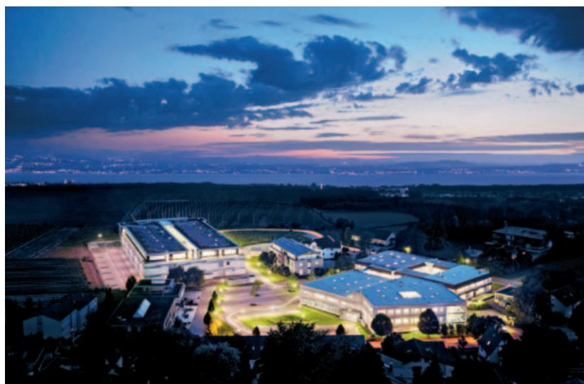
Figura 6 - Il quartier generale di wenglor a Tettnang, nelle immediate vicinanze del lago di Costanza
