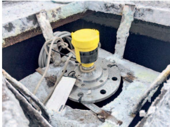
*Il sensore radar VegaPuls 69 è stato utilizzato per la misura di livello nei sili di stoccaggio del sale, grazie anche alle sue antenne insensibili alle sedimentazioni e al funzionamento senza manutenzione*
