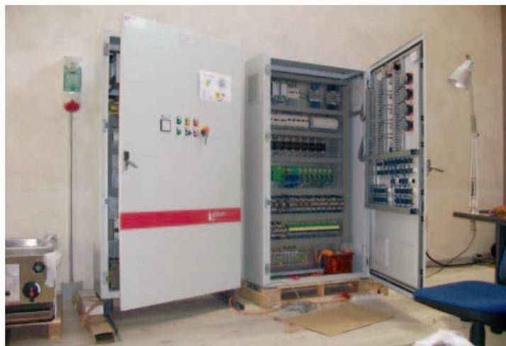
*Nella scuola di Ngarenanyuki, la corrente elettrica è erogata da un inverter che è posto a valle di un bus CC collegato a differenti sistemi di micro-produzione: idroelettrico, solare e diesel*
