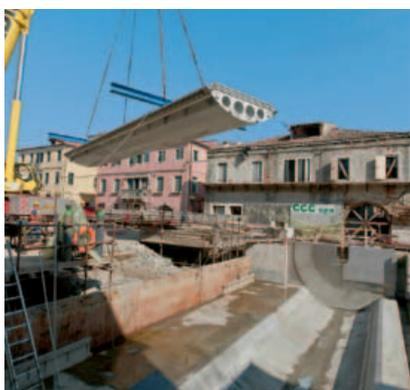
Il Baby Mose di Chioggia, che è una parte del più grande e conosciuto progetto Mose, è un sistema di protezione automatico per la difesa dalle acque alte. Ognuna delle due paratoie utilizzate per il controllo del canale, che attraversa il centro città, è azionata da due motori oleodinamici comandati da due PLC in configurazione ridondata. Tutto il sistema è collegato a un server remoto di supervisione con piattaforma Scada/HMI Movicon 11 di Progea.
